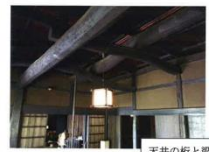
天井の桁と梁
