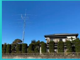
タワー FT1 クラックアップタワー(マスト含む20M) 下段より HF(7/21/28MHz) VHF(50MHz) VHF-UHF(144/430MHz) HF(3.5MHz) GP(144/430MHz)
