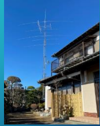
タワー FT1 クラックアップタワー(マスト含む20M) 下段より HF(7/21/28MHz) VHF(50MHz) VHF-UHF(144/430MHz) HF(3.5MHz) GP(144/430MHz)
